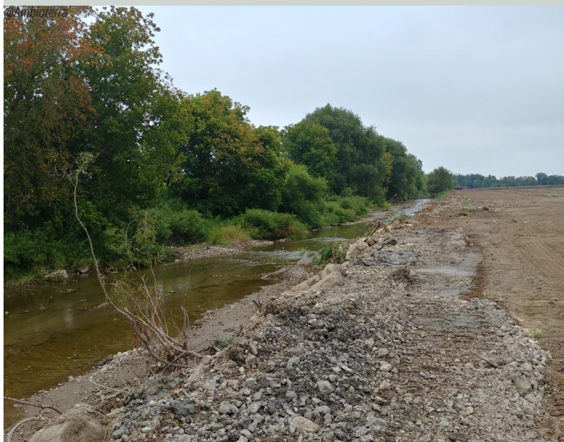
■ Figure 5: Travaux en rivière pour remonter le matériel sur les bord et des destruction de la bande riveraine sur plus d'un km.
